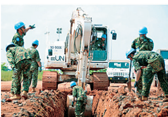
側溝の整備を行う派遣隊員
